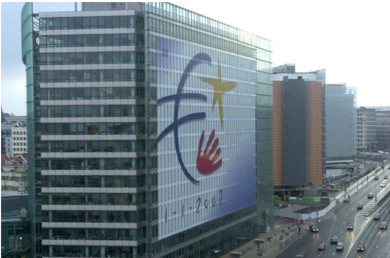
Eines der Bürogebäude der Europäischen Kommission in Brüssel Quelle: European Commission
